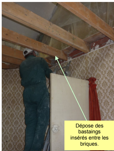
Poutres déposées (côté compteur EDF)
