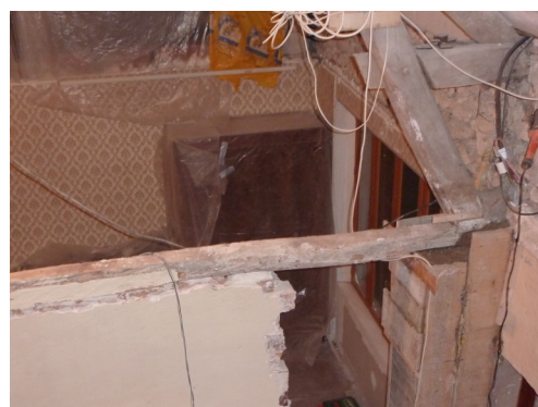
Poutres déposées (côté compteur SUD)
