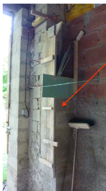
Coffrage pilier nord pour la poutre chêne extérieure (côté garage)
