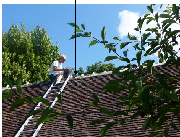
Jointoiement des faîtières
